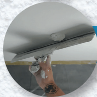
STUC- EN PLEISTERWERK
